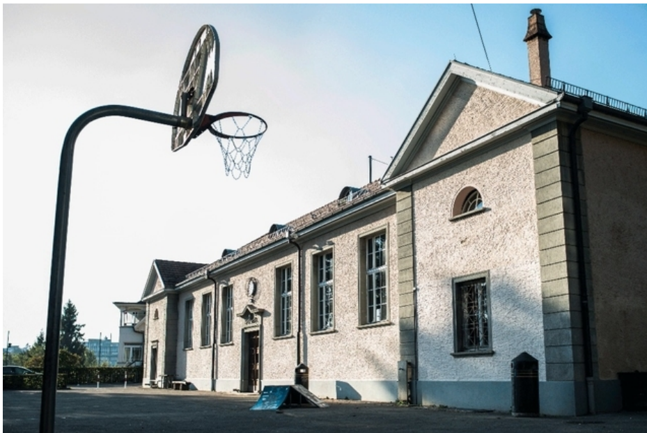
Die Turnhalle des Kirchenfeldschulhauses wird abgebrochen, um dem Erweiterungsbau Platz zu machen. Bild: Franziska Rothenbühler
